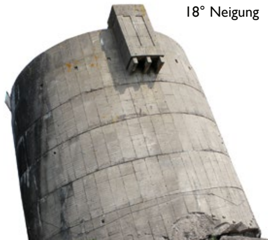
Schiefer Bunker von Sande
